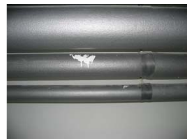
58. kép. A gépészeti csövek takarítása sem történt meg.
