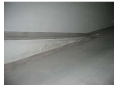
73. kép Ázás nem csak a fenti részen, de a padló közelében is jelentkezik.
