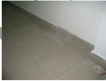
60. kép. A lábazat kialakítása nem esztétikus.
