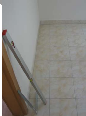
32. kép A derékszögtől való eltérést a padlóburkolat külön hangsúlyozza.
