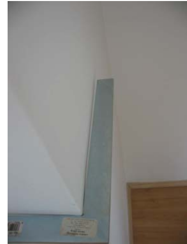
33. kép. A belső él (pozitív sarok) sem derékszögű.
