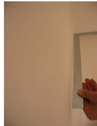
36. kép A fenti szobák sarkai rendre nem elfogadhatóak.
