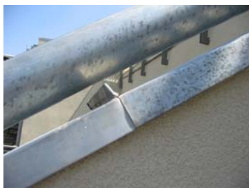
15. kép a szomszédos lakás teraszától elválasztó mellvéd bádofedése miatt a falon elég hamar vízfolyás fog megjelenni.
