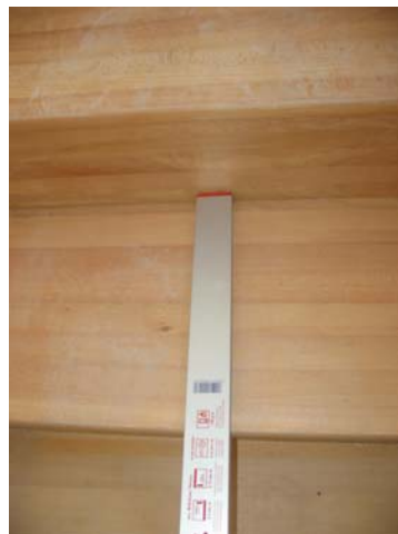
40. kép. Ez a kép és a következő kép két lépcsőfok különböző lépcsőfok-méretét mutatja (felülről).
