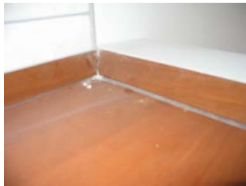
23. kép A laminált parketta sarokszegélye esztétikailag nem megfelelő.
