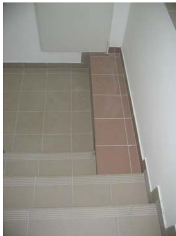
54. kép A lépcsőházban több különböző burkolólap került alkalmazásra.
