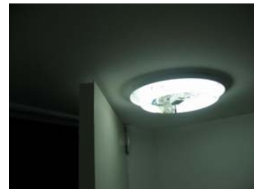
55. kép Az egyik gépészeti helyiség ajtaja használhatatlan. (Nekiütözik a lámpának)
