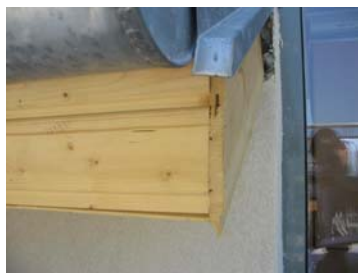
49. kép A lécezés alatt a fa nem lett impregnálva.
