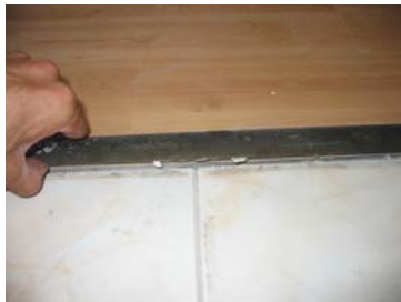
22. kép a különböző típusú padlóburkolatok találkozására nem esztétikus.
