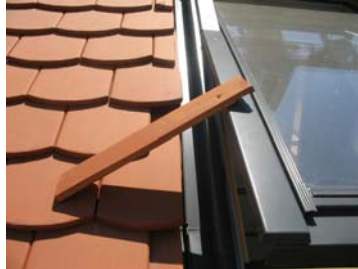
43. kép A tetőablakok mellett a vágott cserepek nem lettek megfelelően rögzítve.
