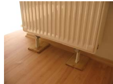
24. kép A felső szintű szobák radiátor talpaknál a parketta kialakítása nem esztétikus.
