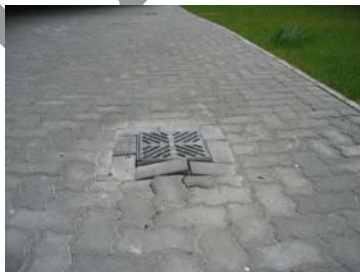
62. kép A földszinti parkolóhelyeknél a vízvezetés nem megoldott. Az összefolyó körül a burkolat sérült.
