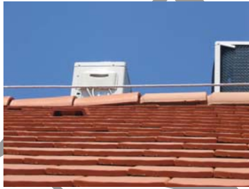
51. kép. A kúpcserpek elhelyezése nem esztétikus.
