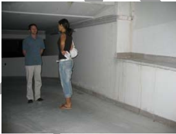
75. kép A kiürítési útvonalon a szabad belmagasság kb. 1.90 m, ami ellentétes az OTÉK előírásaival.
