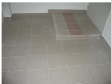
56. kép. A képen három különböző lap alkalmazása látható
