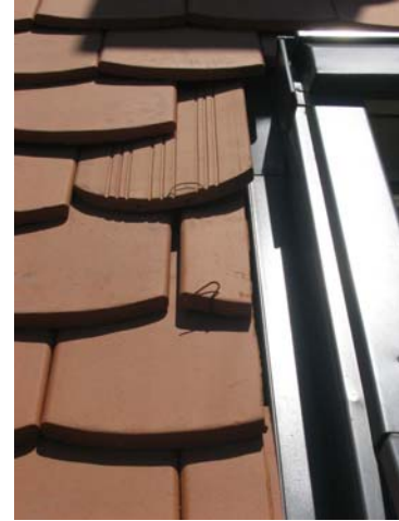
44. kép A tetőhéjalás ezen a helyen nem egyfajta cserepből készült
