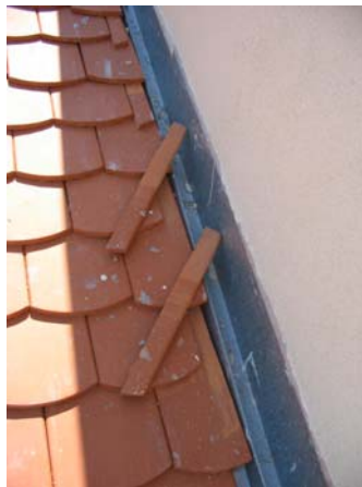
46. kép A tető-fal csatlakozásánál sem lettek rögzítve a vágott cserepek.
