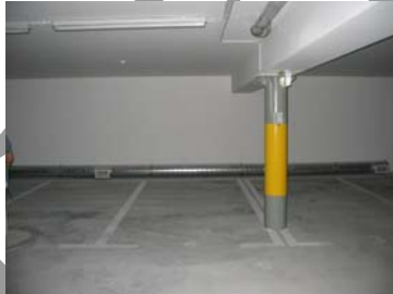
68. kép A parkolóhely végében elhelyezett szellőzőcső védelme nincs megoldva.
