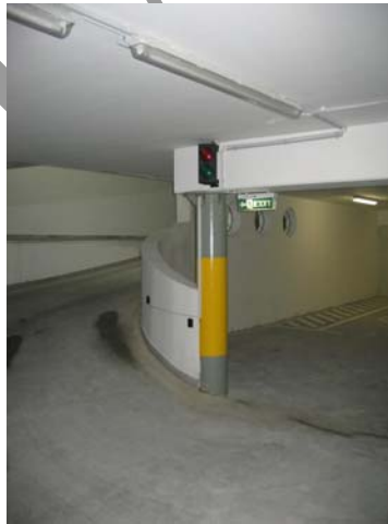
76. kép A kiürítési útvonal szabad belmagasságába még a futóalagos lámpa is beelőd.
