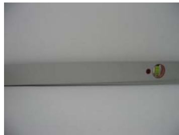
35. kép A fenti szobában a mennyezet alatt a vakolat erősen hullámos (osztályon kívüli minőség)
