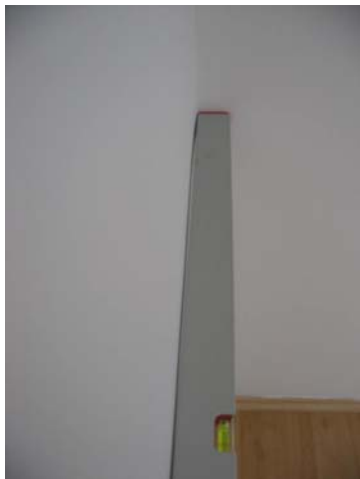
34. kép A vakolt felület síktól való eltérése is erősen kifogásolható.
