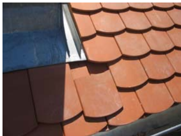
45. kép A vágott cserep itt sem lett rögzítve.
