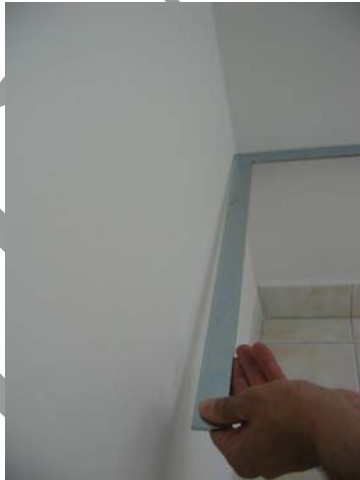
31. kép A sarok derékszögtől való eltérése nem megengedhető mértékű.
