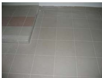
57. kép. A kép közepén is színben eltérő lapok látszakan.
