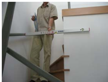
39. kép. A képen egy 1.00 m-es mérőléccezel szimulálva látszi, hogy a szabad karszélesség alig több, mint 65 cm.
