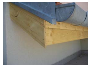
50. kép A fa szerkezeteket gombamentesíteni kellett volna.
